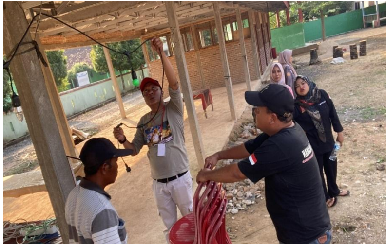
Gambar 4. Pemasangan Lampu di Area Kios Berjualan
